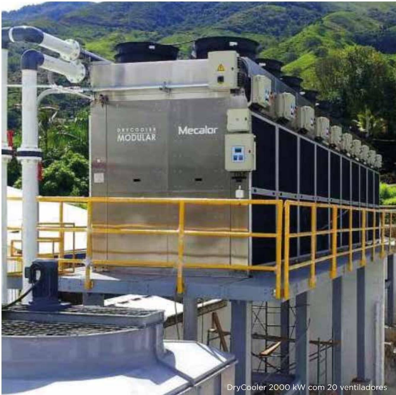
DryCooler 2000 kW com 20 ventiladores
